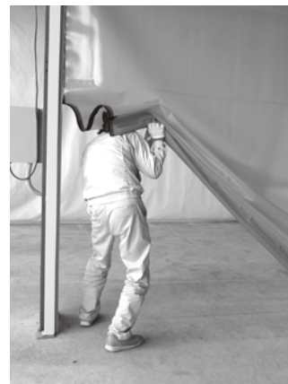
③ シートを潜り通過します。外れたシートは以下のシート復帰方法にて再度上限位置まで上げ復帰します。
