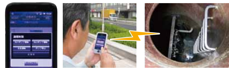
遠隔地からポンプやバルブなど機器操作、設定変更などが行えます。
