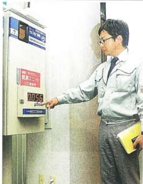
小松電機産業が商品化した放射線モニタリングシステム。同システムで測定したデータはパソコンや携帯電話で確認できる。松江市乃木福富町、同社
